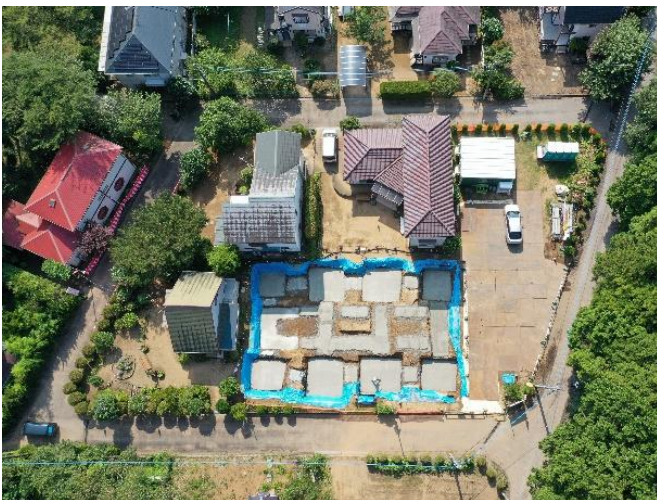
吉祥なる定礎レンガ安置後、コンクリート打設された浄心庵「シーマー（戒壇）・仏塔」建物基礎部
