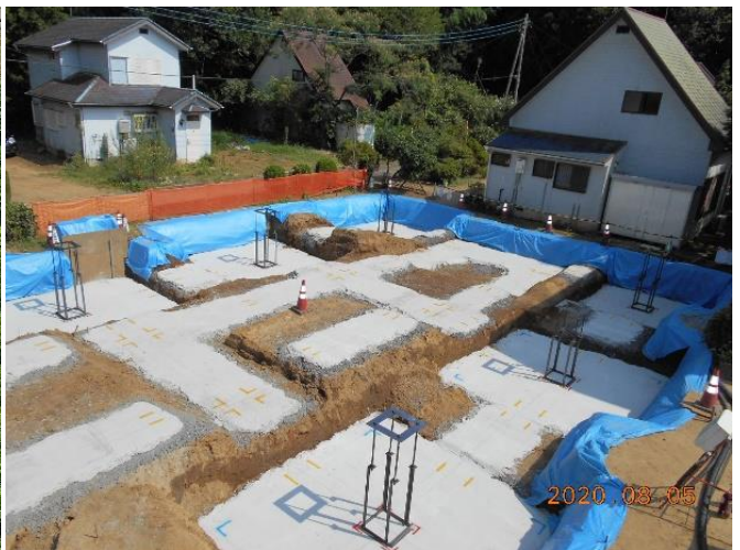
吉祥なる定礎レンガ安置後、コンクリート打設された浄心庵「シーマー（戒壇）・仏塔」建物基礎部
