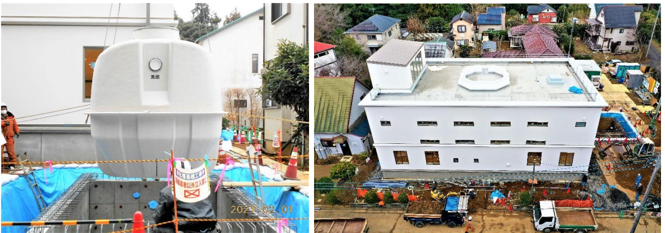
浄化槽設置などの外構工事
