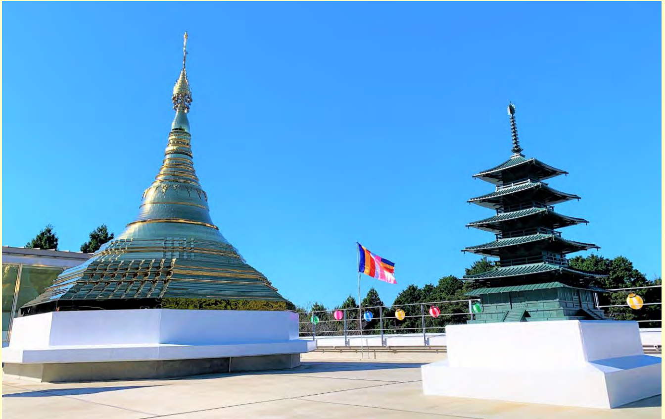
2022年9月2日（金）八日目のウボサタの日、日本茨城県銚田市 浄心庵戒壇「Sāsana Sirī Dhara Simā（お釈迦さまの教えが伝わるために品位を保つ浄心庵戒壇）」屋上において、大プロジェクトの主なる最も重要なシェーダゴンパゴダ形仏塔・法隆寺形五重塔の仏塔建立は大成功いたしました。工事は2日間にわたって行われました
